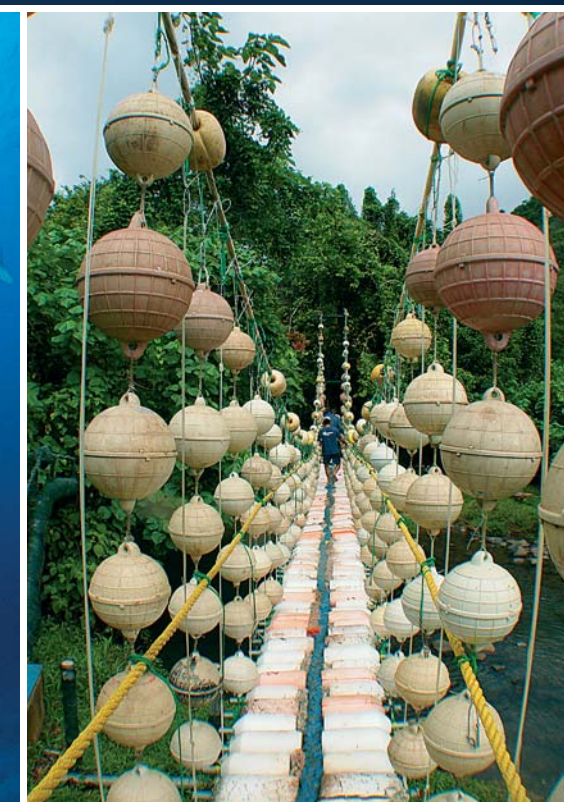
Brücke auf Cocos nahe der Rangerstation: Nur aus Longlines, Haken und Bojen zusammgebaut
